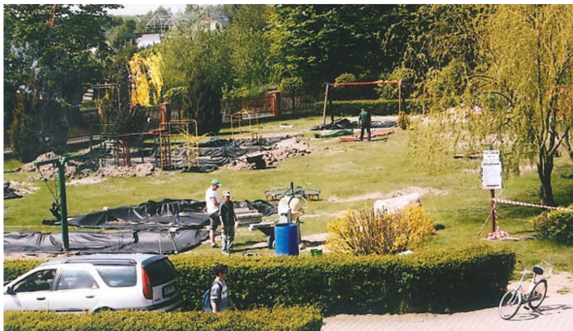
Zgodnie z wytycznymi Nadzoru budowlanego, wszystkie szkoły przystąpiły do gruntownej modernizacji placów zabaw przy szkołach, tak aby nawierzchnia wokół urządzeń zapewniała bezpieczeństwo dla dzieci. W pracy przy SP w Zalesiu zaangażowali się rodzice oraz uczniowie starszych klas gimnazjum
