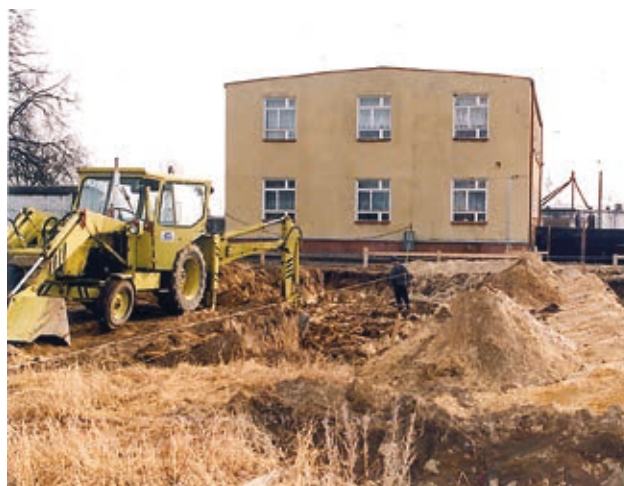
W lutym rozpoczęła się rozbudowa Szkoły Podstawowej w Zalesiu
