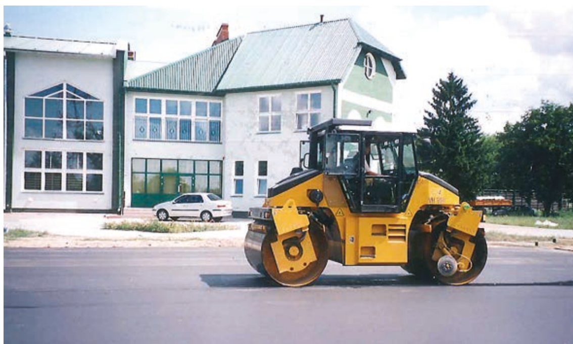
W wakacje pracownicy firmy ZIB zniwelowali teren przy nowej szkole i wylali asfalt pod boisko do piłki ręcznej
