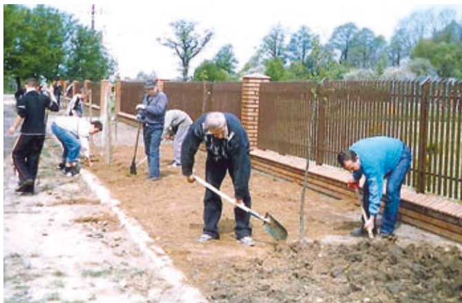
Prace przy sadzeniu lip
