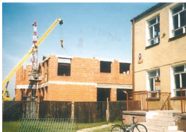
Nowo budowane skrzydło szkoły wyrasta z ziemi coraz wyżej... (czerwiec 2001 r.)
