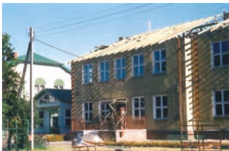
W maju nadal jeszcze trwał generalny remont starego budynku szkoły
