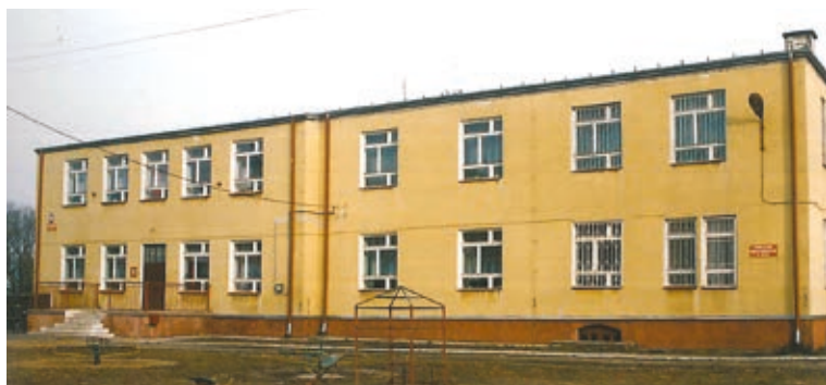
Budynek szkoły od strony południowej
